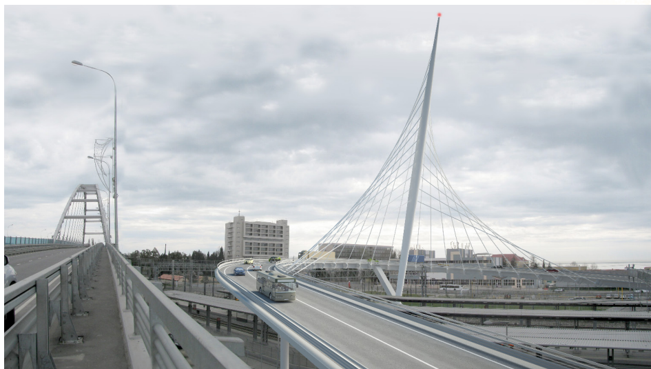
Рис. 4. Мост-эстакада в Адлерском районе г. Сочи
